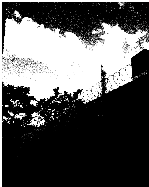
FOTO 63: RECUPERAÇÃO DE CERCA ELETRIFICADA E CONCERTINAS.
