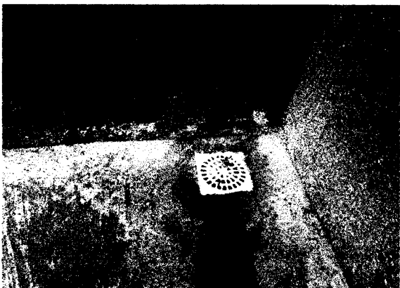
FOTO 09: CAIXA SIFONADA, PVC, ASSENTADA NO ESTACIONAMENTO COMO MECANISMO DE DRENAGEM.
