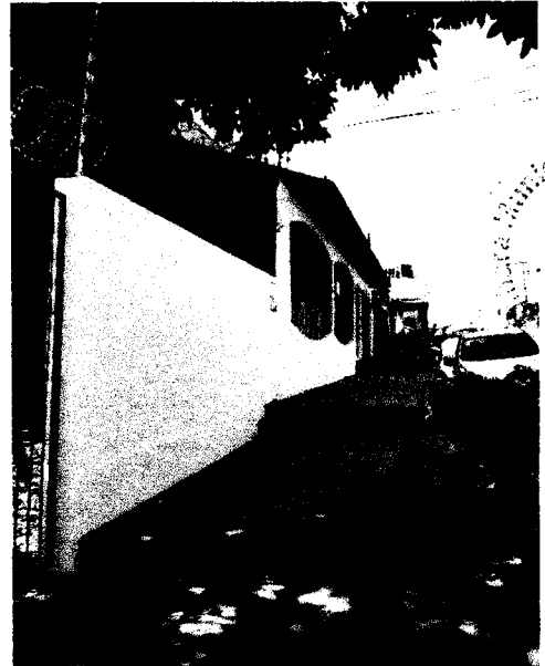
FOTO 58: PINTURA DA FACHADA DA CASA RECUPERADA, DETALHE PARA PINTURA EM PISO CIMENTADO.
