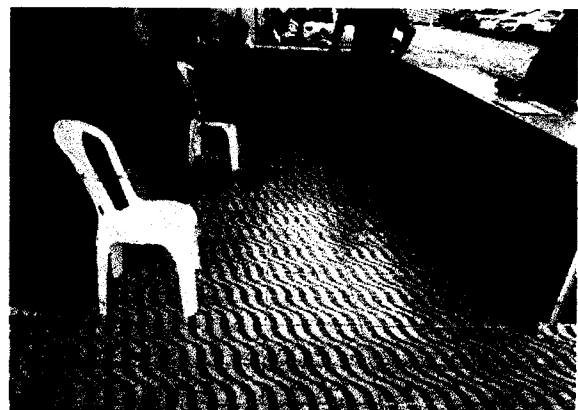
FOTO 10: ALVENARIA DA MURETA ACABADA, PISO DA RECEPÇÃO DO ESTACIONAMENTO.
