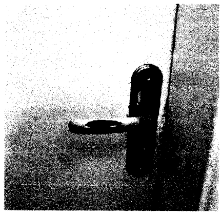
FOTO 18: FECHADURA DE EMBUTIR, INSTALADA NA PORTA DE ENTRADA DA SALA DA COORDENADORIA DE LICITAÇÃO E CONTRATOS.
