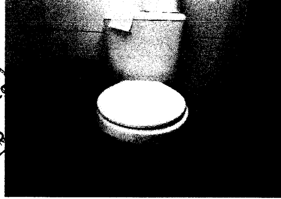
FOTO 08: VASO SANITÁRIO COM CAIXA ACOPLADA, SUBSTITUÍDO NO BANHEIRO FEMININO DA COPA.
