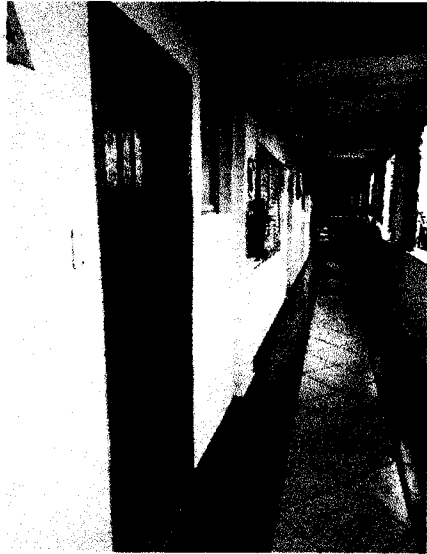
FOTO 49: EXECUÇÃO DOS SERVIÇOS DE PINTURA NO CORREDOR DO 2 PAVIMENTO.
