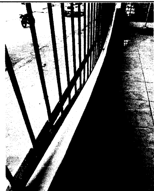
FOTO 43: DETALHE PARA PINTURA EM ESMALTE SINTÉTICO NA GRADE - VERMELHO GOYA.
