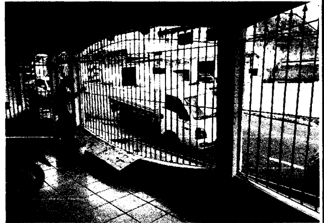
FOTO 38: APLICAÇÃO MANUAL DE PINTURA EM ESMALTE SINTÉTICO NAS GRADES - VERMELHO GOYA.
