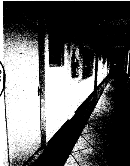
FOTO 54: EXECUÇÃO DOS SERVIÇOS DE PINTURA NO CORREDOR DO 1 PAVIMENTO.
