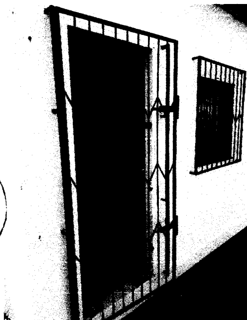
FOTO 44: DETALHE PARA PINTURA EM ESMALTE SINTÉTICO NAS GRADES - VERMELHO GOYA E PINTURA EM VERNIZ MOGNO NA PORTA E JANELA.
