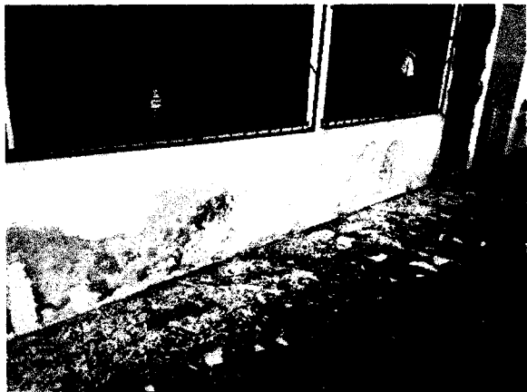
FOTO 03: REMOÇÃO DA CAMADA DE PINTURA.
