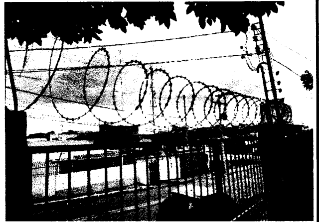
FOTO 62: RECUPERAÇÃO DE CERCA ELETRIFICADA E CONCERTINAS.
