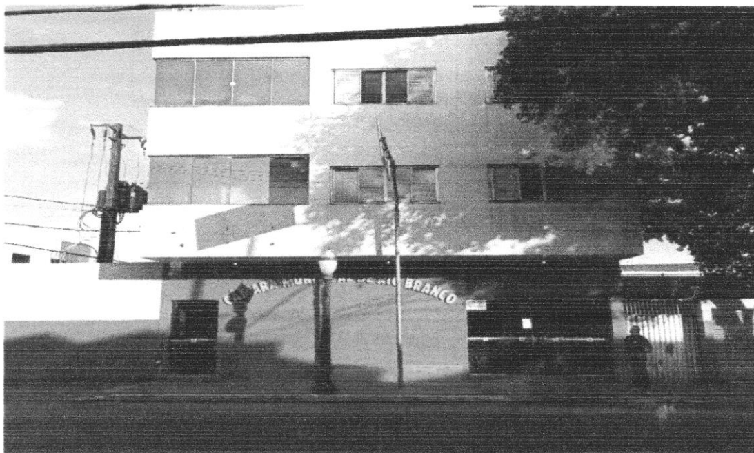
Vista Frontal do Edifício
