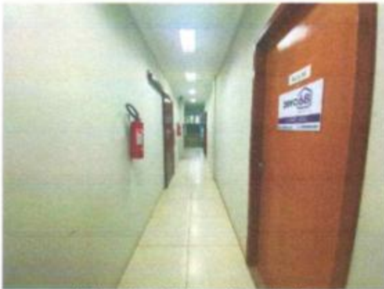
Foto 11 – Extintor de incêndio
