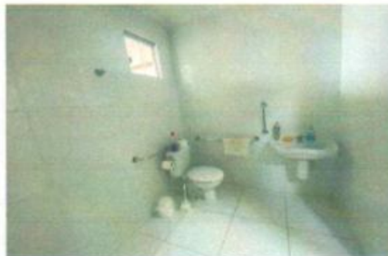
Foto 06 - Banheiro PNE em comum
