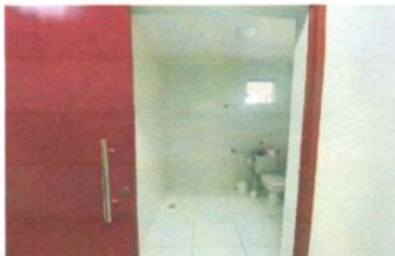
Foto 05 – Banheiro PNE em comum
