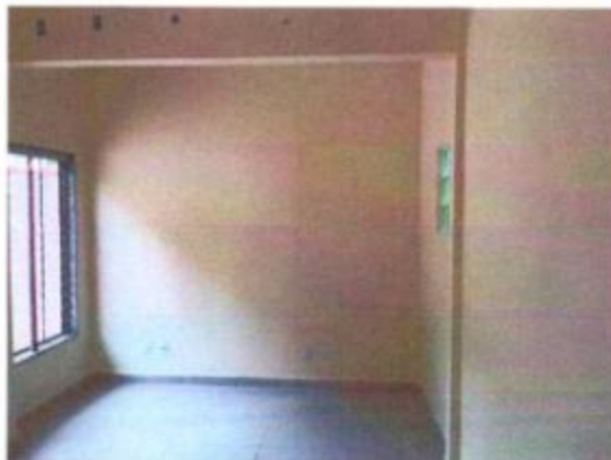
Foto 12 – paredes internas da sala
