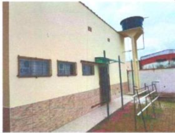
Foto 02 – Fachada dos fundos
