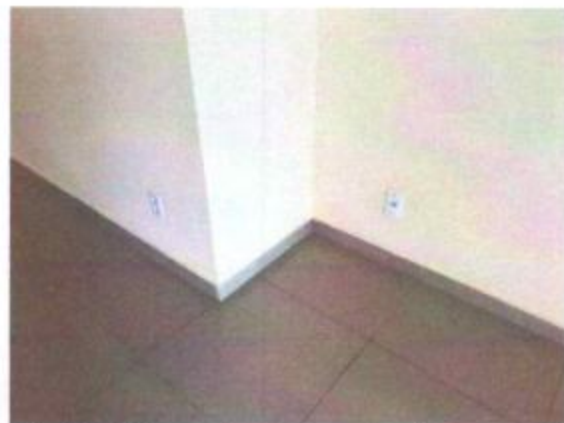
Foto 10 – Piso e rodapé em conformidade
