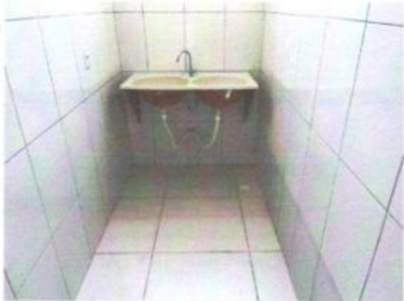
Foto 15 – Área de Serviço
